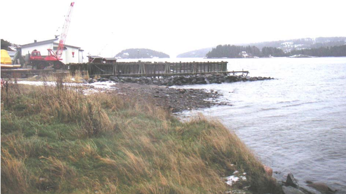
Bakom det f d färjeläget ligger Sunds Marin. Kranen avses ersättas av en rälsburen portalkran.
